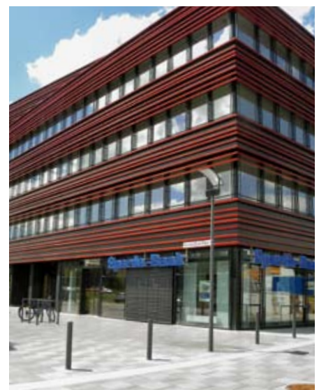
Die Fondsimmoblie in Böblingen: ein Hingucker im Eingangsbereich des Flugfelds.
